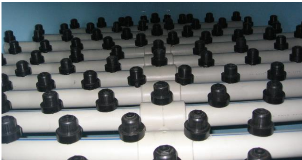
Рисунок 2 Трубчатый дренаж высокого сопротивления с центральной трубой и боковыми дренами со щелевыми колпачками.
